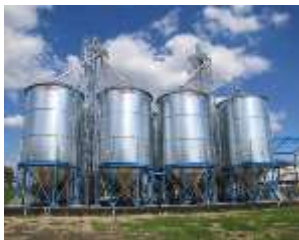
das Blechsilo - silos blaszany
