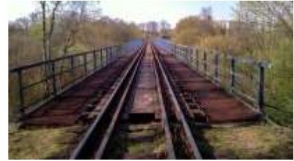
die Eisenbahnbrücke - most kolejowy
