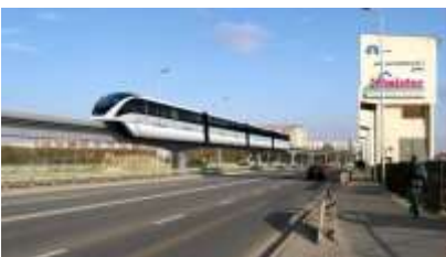
die Hochbahn - kolej nadziemna
