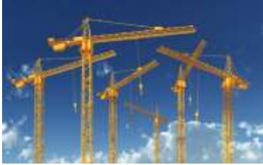
die Kramanlage - urządzenia dźwigowe
